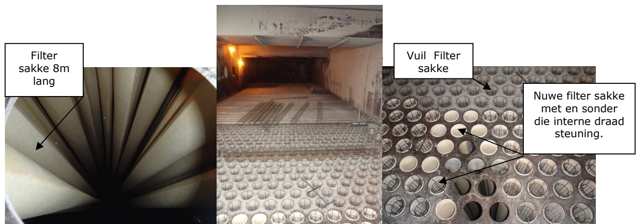
Figuur 2: Die binnekant van 'n tipiese sak filter struktuur.
