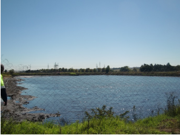
Photo 25. – Reclamation dam P08.
