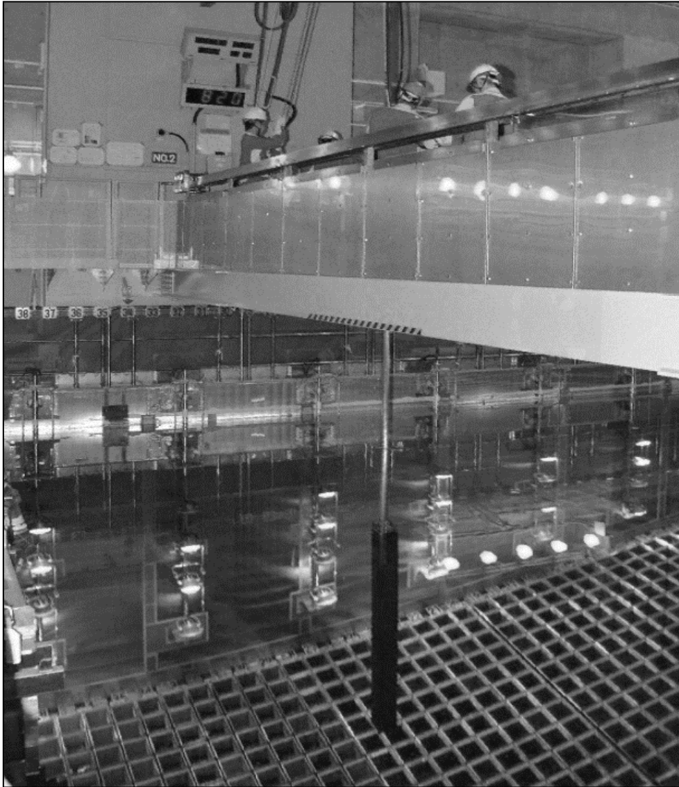
Figuur 22: Kernbrandstofelement wat geskuif word vir berging in 'n poel vir gebruikte brandstof soortgelyk aan Koeberg
