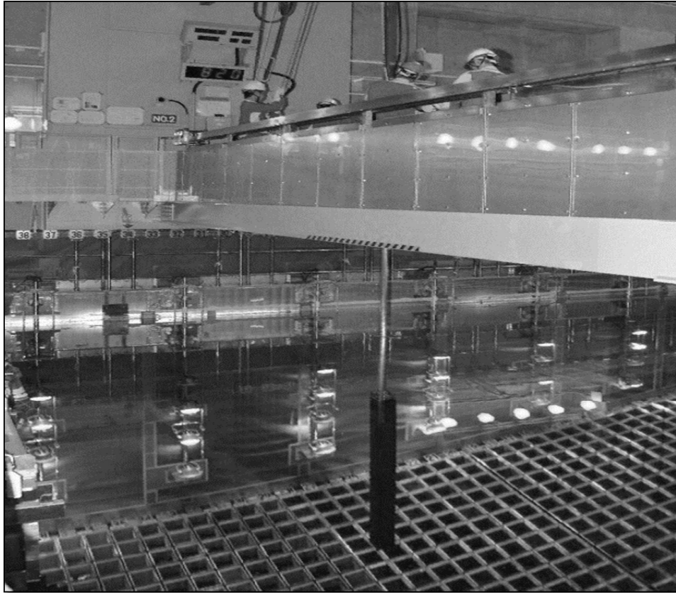
Umfanekiso 23: I-assembly yamafutha isiwa eluginweni kwidama lamafutha asetyenzisiweyo elifana nelaseKoeberg
