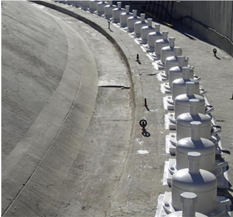
Figuur 8: Kraak op inperkingskoepel verseël en bedek
