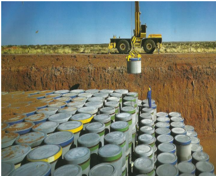
Figuur 12: Radioaktiewe afval in betonafvaldromme wat by Vaalputs- Nasionale Afvalverwyderingsfasiliteit geberg word
