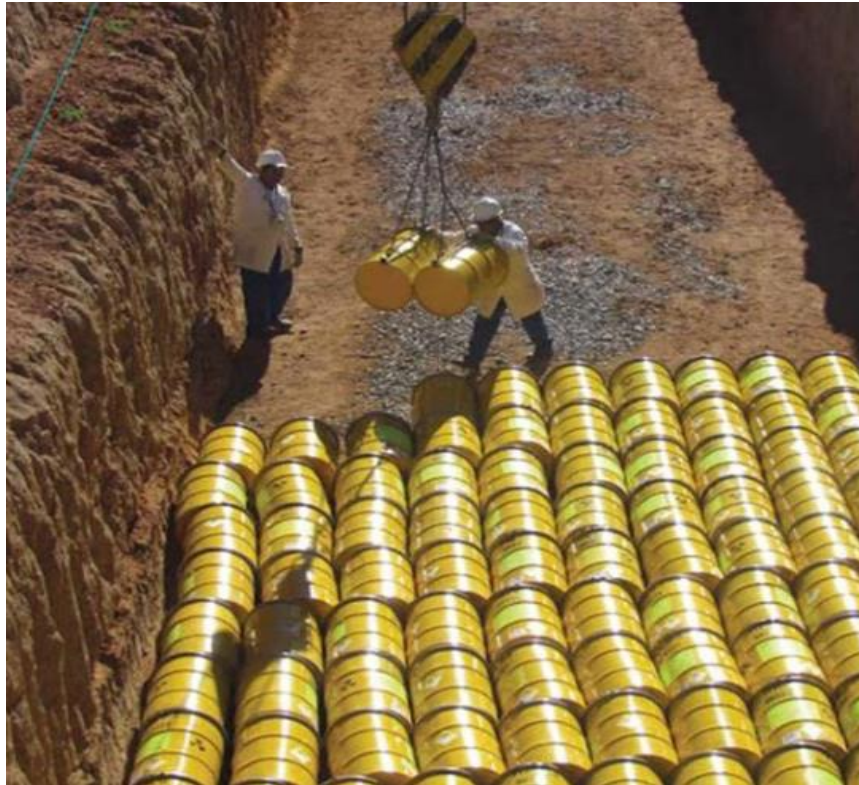
Figuur 11: Radioaktiewe afval in staaldromme wat by die Vaalputs- Nasionale Afvalverwyderingsfasiliteit geberg word
