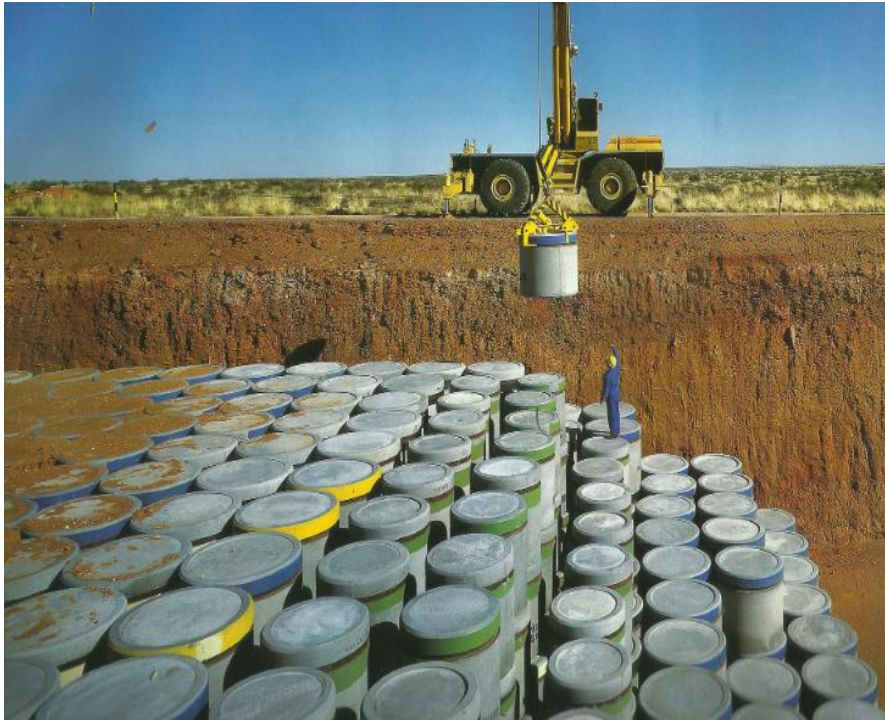
Figuur 11: Radioaktiewe afval in betonafvaldromme wat by Vaalputs- Nasionale Afvalverwyderingsfasiliteit geberg word
