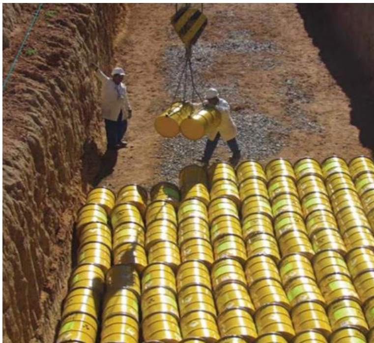
Figuur 10: Radioaktiewe afval in staaldromme wat by die Vaalputs- Nasionale Afvalverwyderingsfasiliteit geberg word
