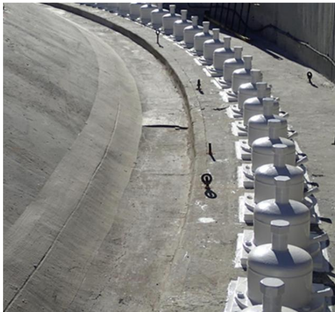
Figuur 8: Kraak op inperkingskoepel verseël en bedek
