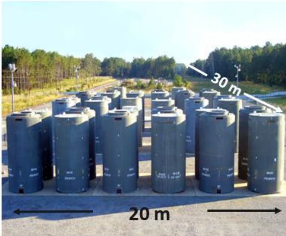
Figuur 16: 'n Voorbeeld van 'n droëbergingshouer-area vir gebruikte kernbrandstof
