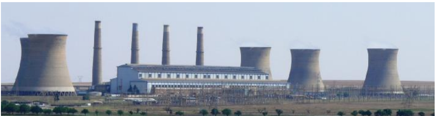
Die voorgestelde uitbreiding van aswegdoenfasiliteite vir die Camden-kragstasie net buite Ermelo in Mpumalanga.
