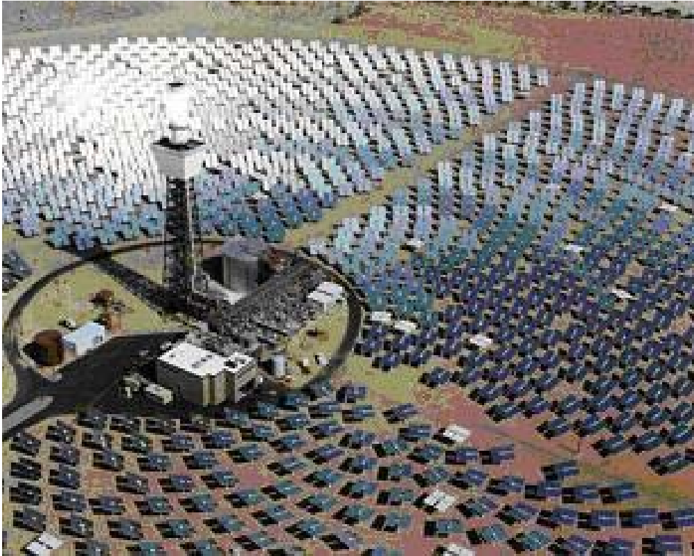
Figuur 2: Voorbeeld van 'n sonkrag-aanleg wat gebruik maak van 'n sentraal-ontvanger ("central receiver") tegnologie. Hierdie is 'n 10MW demonstrasie-aanleg wat in die Verenigde State gebou is – gebruiksreg van beeldmateriaal NREL
